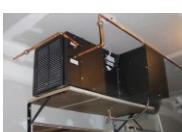
**B.** Installez l'appareil dans un endroit facilement accessible pour toute réparation et laissez au moins 1 mètre de chaque côté du système de refroidissement pour faciliter l'entretien du climatiseur.
