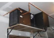
**B.** Montare l'unità in una posizione che sia facilmente accessibile per i futuri controlli e che lasci almeno un metro di spazio su entrambi i lati del sistema per la manutenzione.
