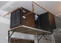
**A.**如图所示葡萄酒守护者管道系统必须水平安装在其基座上，并调整两端误差不超过 $+/-1/4$ 英寸(0.6厘米)，两侧面不超过 $+/-1/8$ 英寸 (0.3厘米)。
